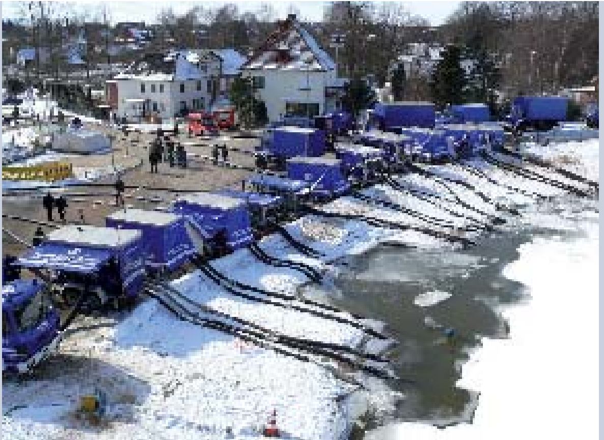
Schmelzwasserdruck – ein Wehr droht einzubrechen. Quelle: Bundesanstalt Technisches Hilfswerk (THW)
